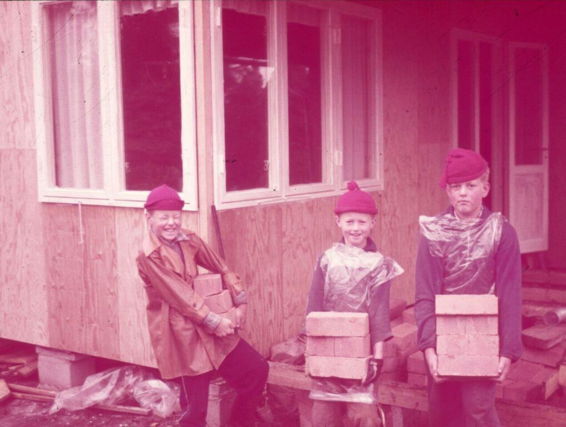
Skorstensstocken ska muras upp. Per, Lasse och Mats Bjurvald bär tegelstenar. 1959.
