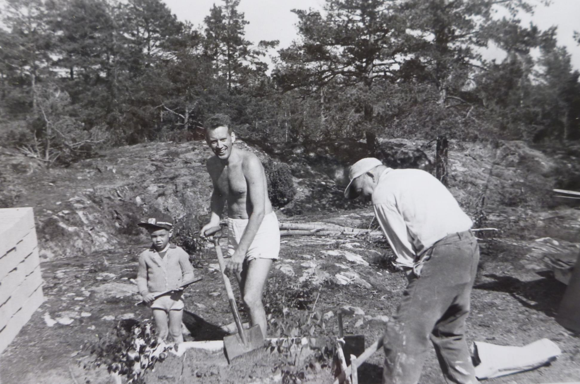
Tre generationer Behrenfeldt, Mats, pappa Åke och Morfar, blandar bruk för murning av grunden till nya huset 1960.
