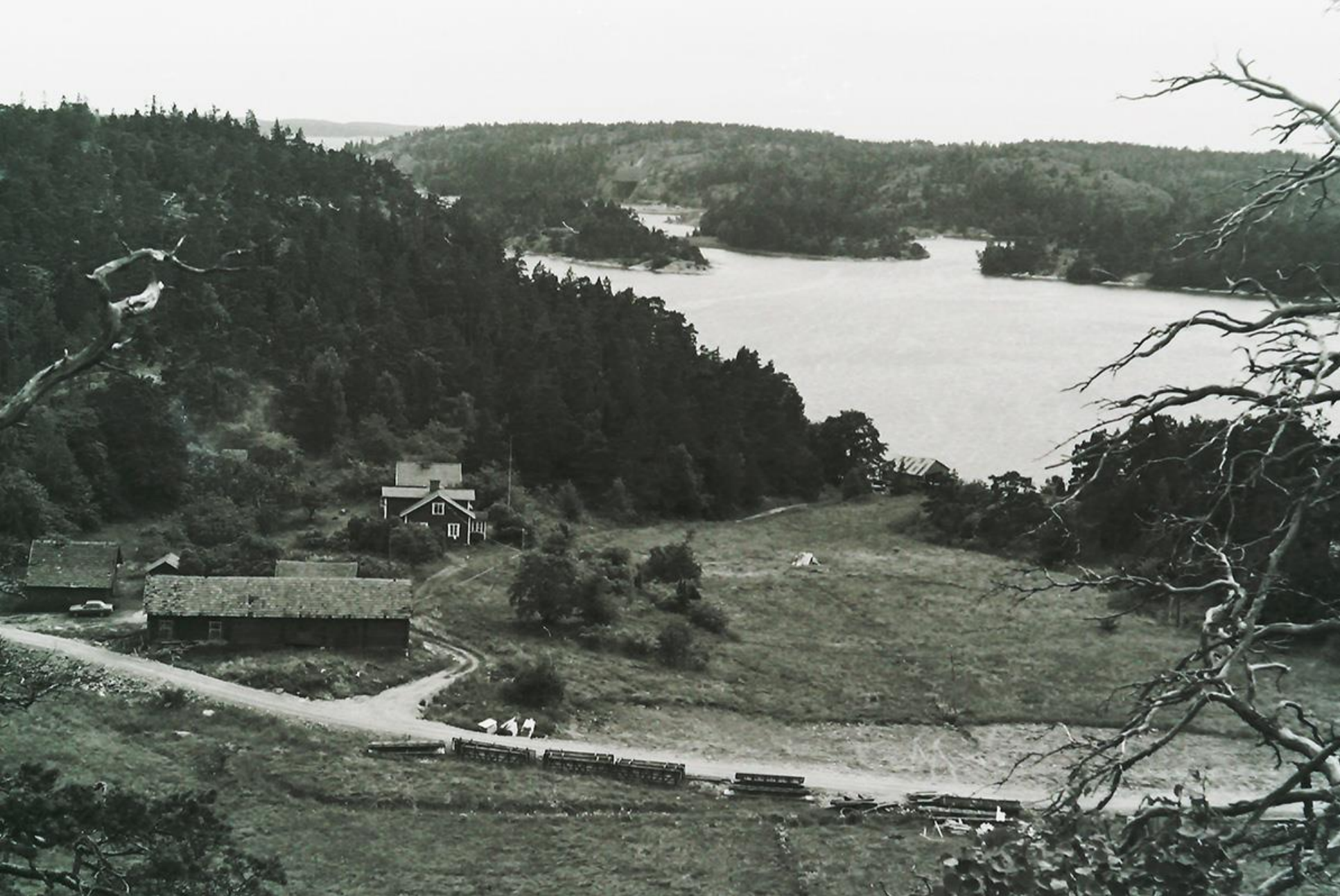
Bjurshagstorpet, årtal okänt. Obs. tunnelmynningen på Älvsnabben i fonden.
